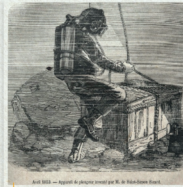
L'appareil chimico-sauveur de P.-A. de Saint-Simon-Sicart en 1853. Sur le dos du scaphandrier : deux cylindres en cuivre de 10 litres contiennent de l'oxygène et au milieu une boîte contient de l'eau de chaux. (Almanach du Magasin Pittoresque 1854 - L'illustration avril 1853, coll. F. Brun).
