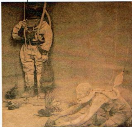
13. Au premier plan l'appareil Fernez employé pour la pêche des éponges en Tunisie. Au second plan un scaphandre Cabirol. (extrait carte postale Musée Salammbô)
