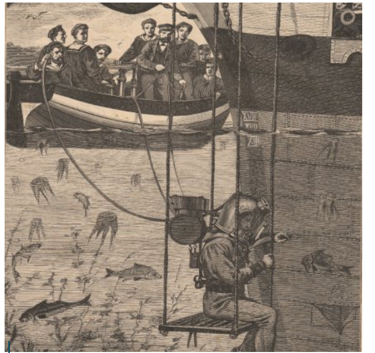
Travaux immergés avec régulateur et casque à trois boulons, « Histoire populaire des Sciences / Inventions et découvertes », XIX e siècle.
